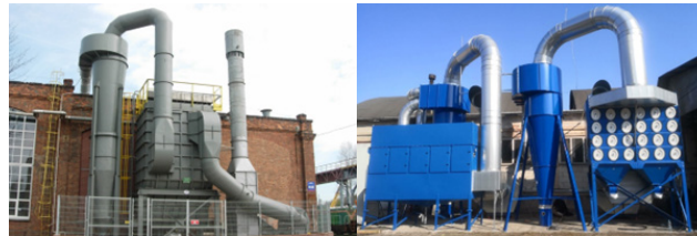
Rys. 4. Wstępna separacja pyłów za pomocą odpylaczy cyklonowych [14] Fig. 4. Preliminary dust separation using cyclone dust collectors [14]
