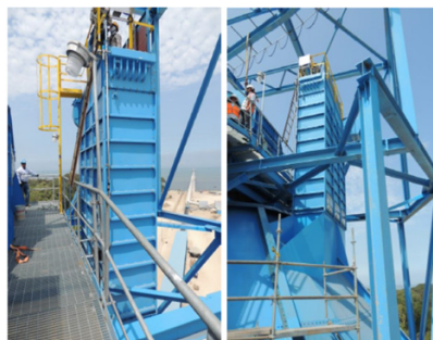
Rys. 12. Zastosowanie instalacji odpylającej na wlocie do bunkrów magazynowych węgla w porcie Santa Maria (CFT Polska, 2024) Fig. 12. Application of a dust removal installation at the inlet to coal storage bunkers in the port of Santa Maria (CFT Polska, 2024)
