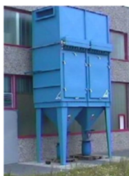
Rys. 6. Odpylacz workowy pulsacyjny z możliwością magazynowania usuwanego pyłu (CFT Polska, 2024)
