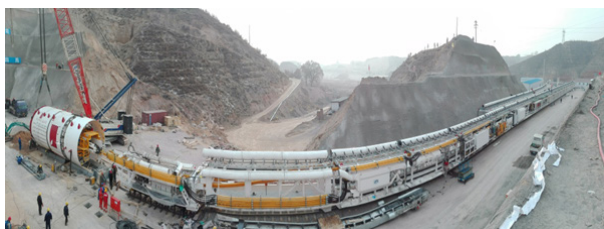
Rys. 14. Instalacja odpylająca na maszynie TBM (Tunnel Boring Machine) (CFT Polska, 2024)
